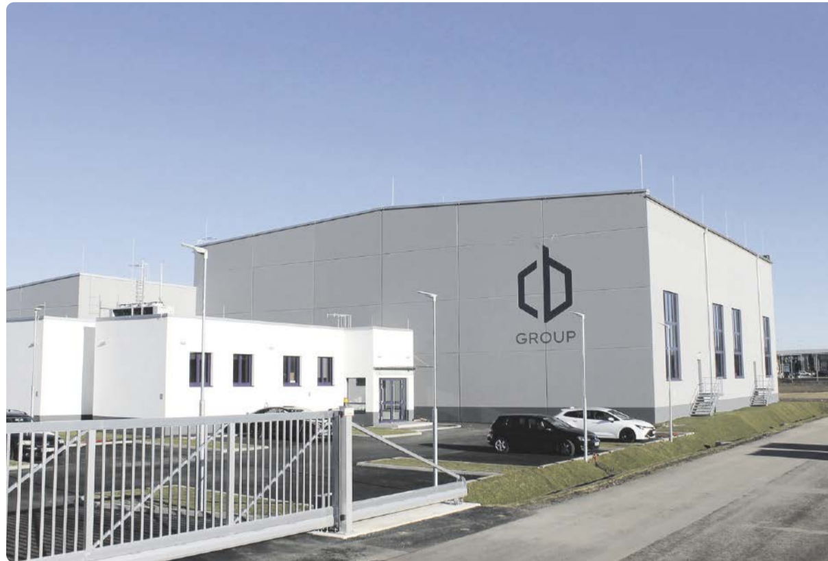
Neuer Betriebsstandort der CB Chemie in Siegendorf, Österreich
